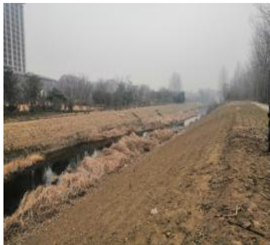
小洪河河道边坡现状
