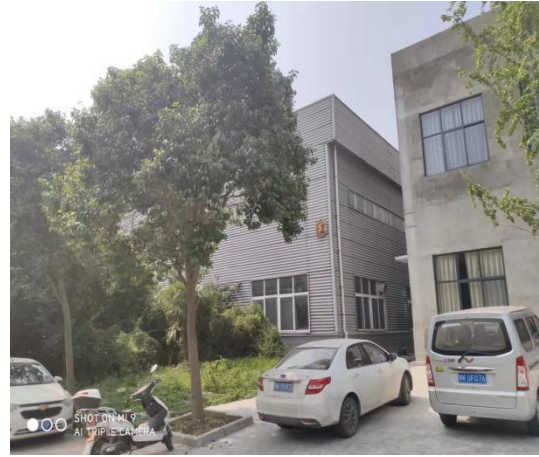
南侧许昌市泰达电气有限公司
