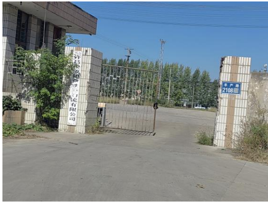
项目南侧中原铁路物流园
