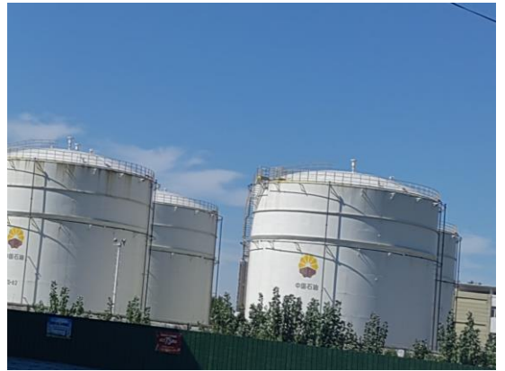
项目西侧中国石油油库
