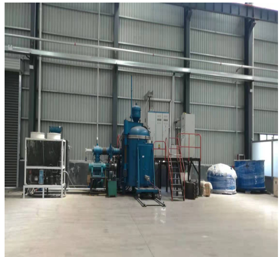
拟建 X 检验室北侧生产线
