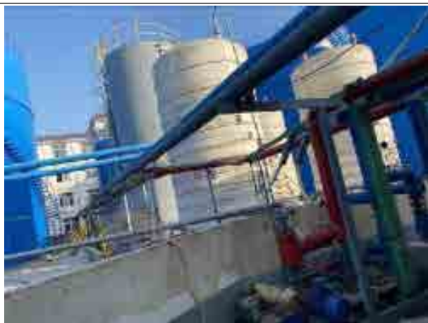
现有工程原料液罐区
