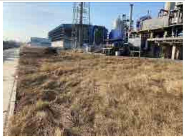
本项目(定向转化装置)拟选厂址现状空地
