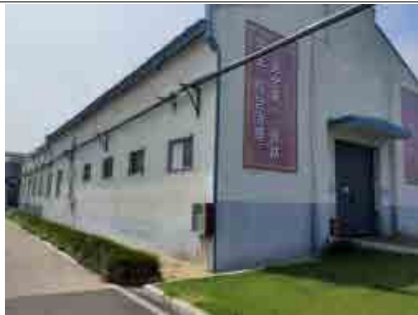
本项目(预处理技改工程)拟选厂址现状闲置厂房
