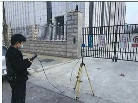
众旺 110kV 变电站北侧厂界（大门侧）4#
