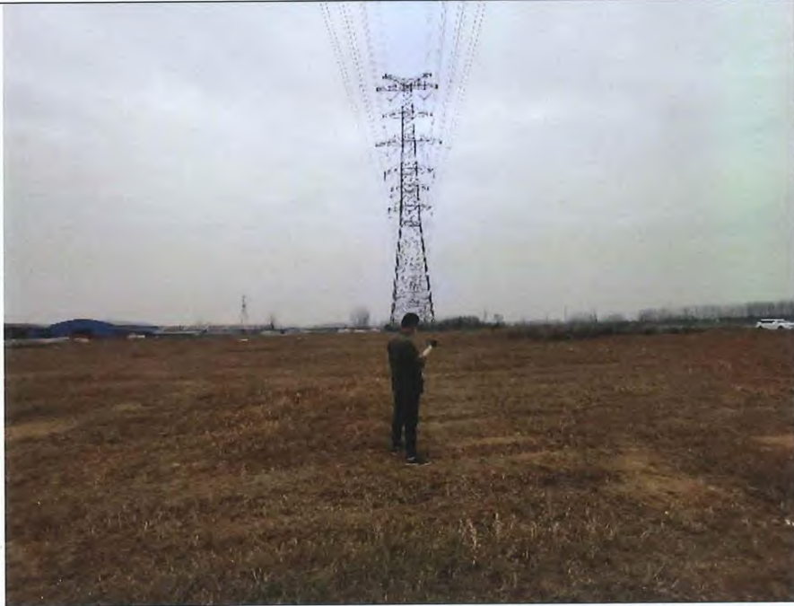
220kV 汇普 I 线、220kV 英普 I 线、110kV 普金线、110kV 普干线同塔四回线路噪声现状
