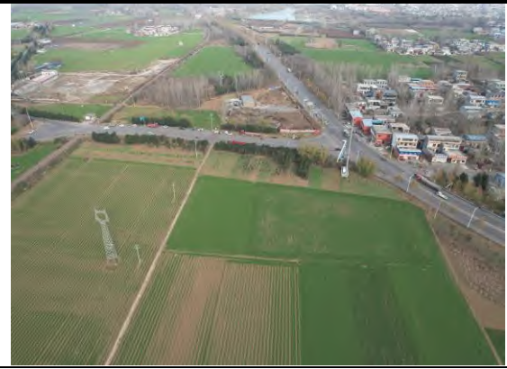
钻越襄城西—乾明 220/110kV 混压四回线路
