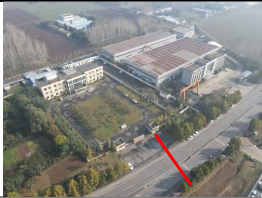
拟建乾明-首山 \pi 入襄城西变 110kV 线路跨越乾明大道
