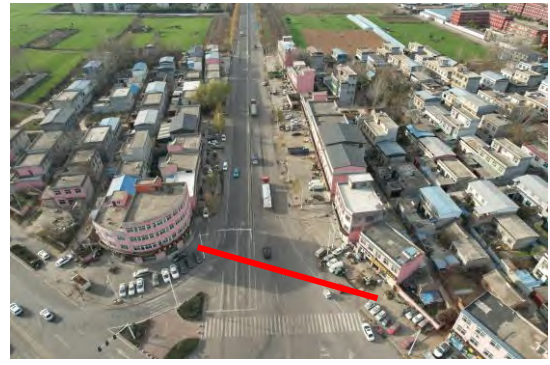
拟建乾明-首山 \pi 入襄城西变 110kV 线路跨越紫云大道
