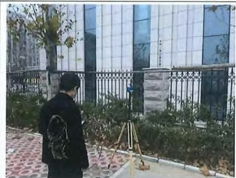
众旺 110kV 变电站西侧厂界 2#
