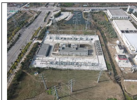
屯田 220kV 变电站站址航拍
