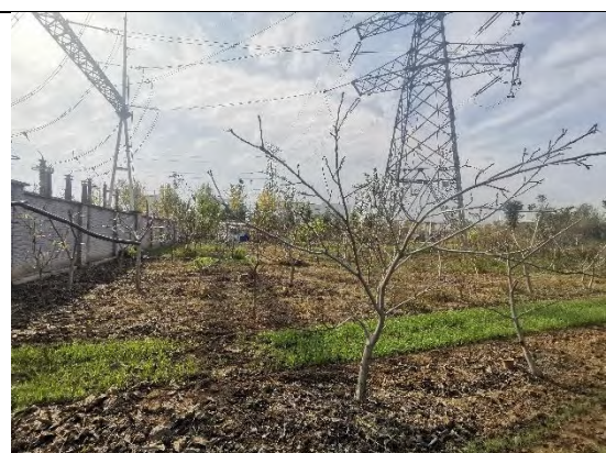
屯田 220kV 变电站西侧（220kV 出线侧）
