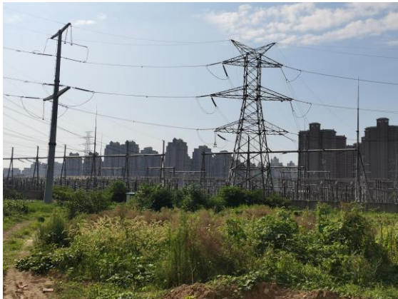
充电站区域现状及南侧变电站
