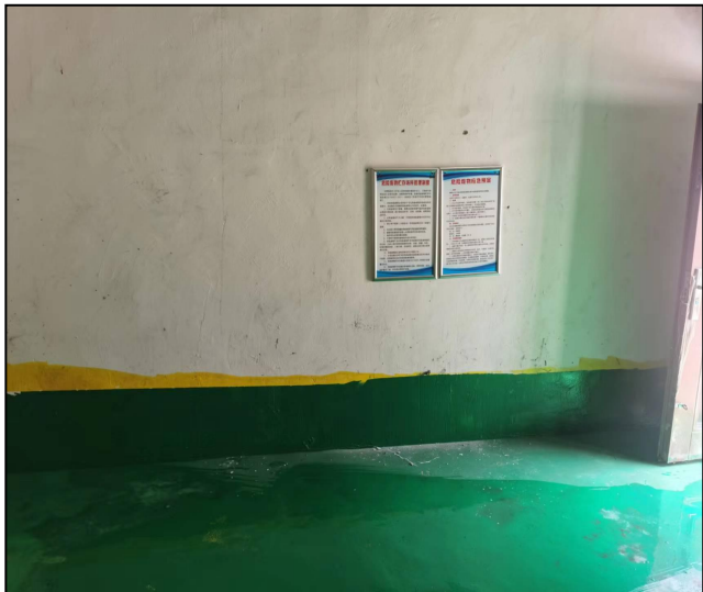
厂区危废暂存间
