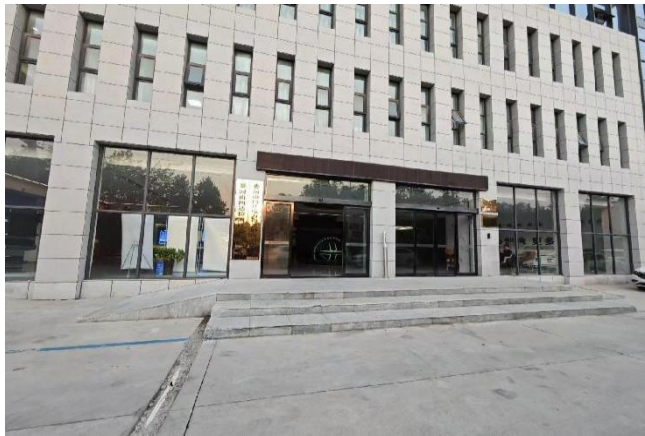
西侧-河南四达电力设备股份有限公司中原电气谷基地
