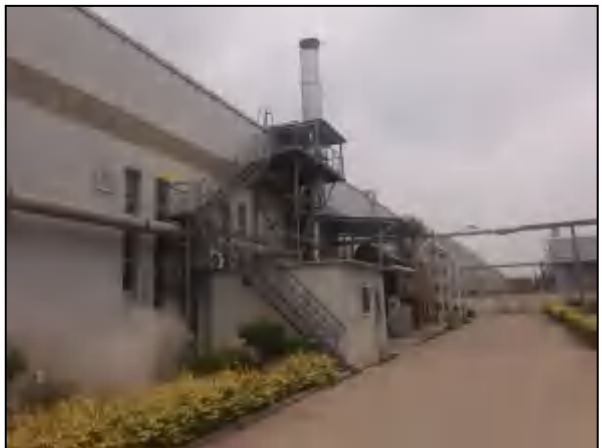
现有有机废气治理设施及在线监控室
