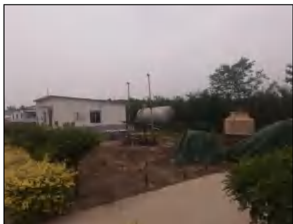
现有地埋罐区
