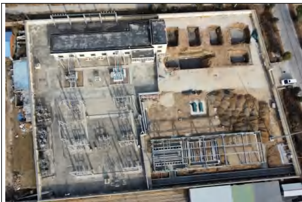
图2-1 110kV 桂村变电站航拍照片（施工中）
