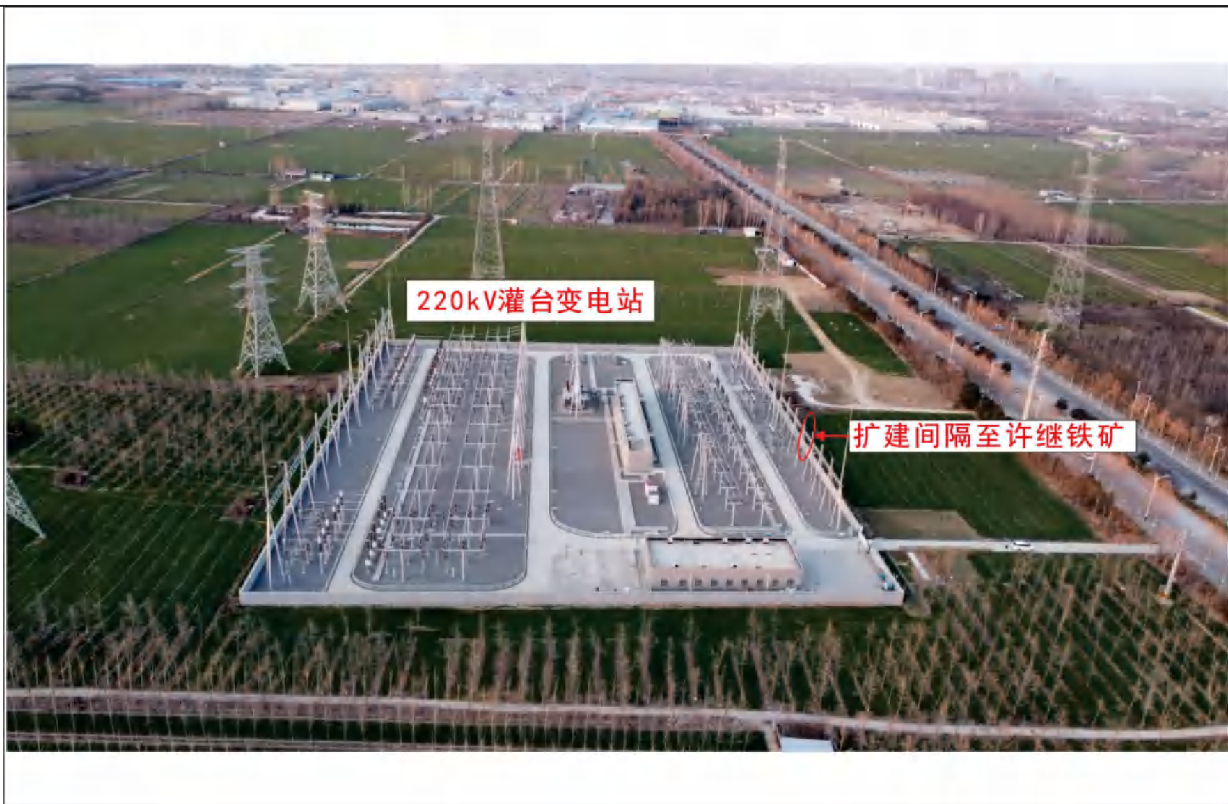
图 3-1-2 220kV 灌台变电站间隔扩建侧现状照片
