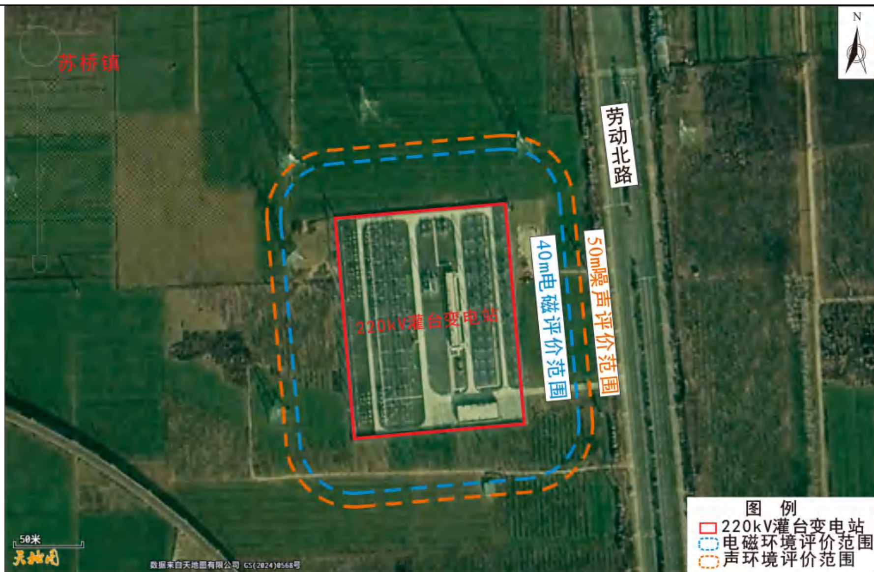
图 3-1-1 220kV 灌台变电站间隔扩建侧现状示意图
