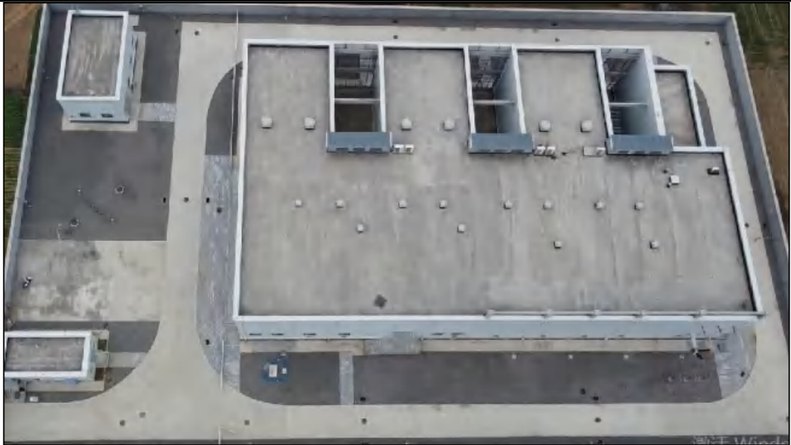
图 2-6 罗庄 220kV 变电站现状照片
