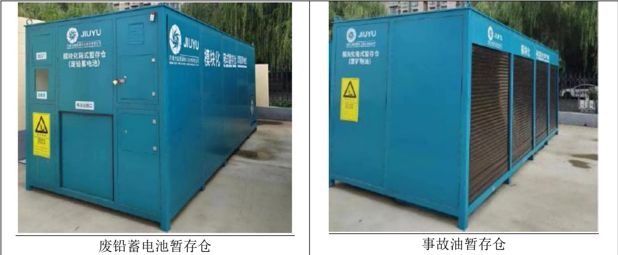
图4-8 危险废物暂存场所
