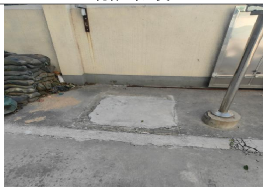
原有事故油池
