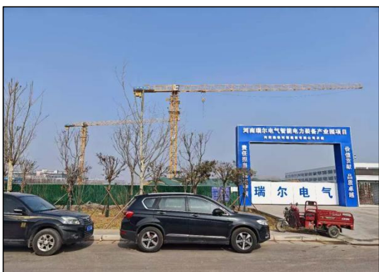
瑞尔电气产业园（在建）
