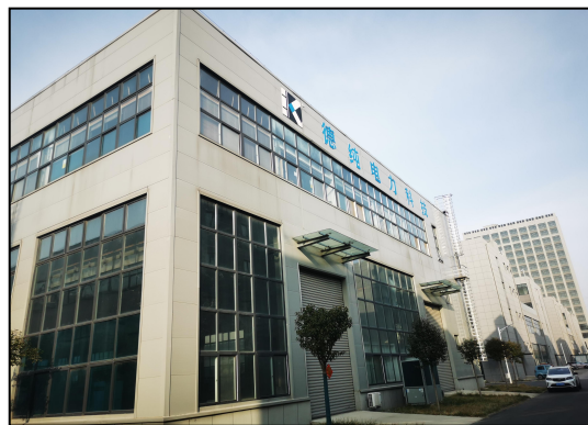
北侧 D3 德纯电力
