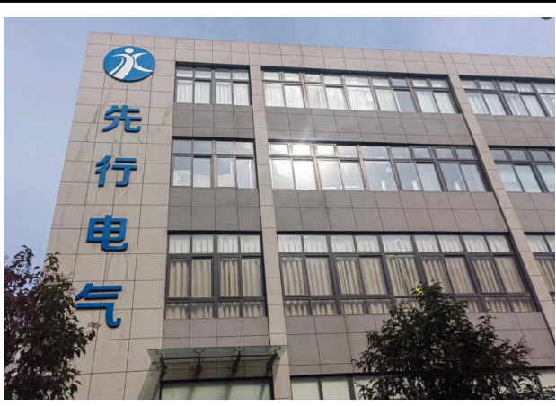
项目北侧—先行电器
