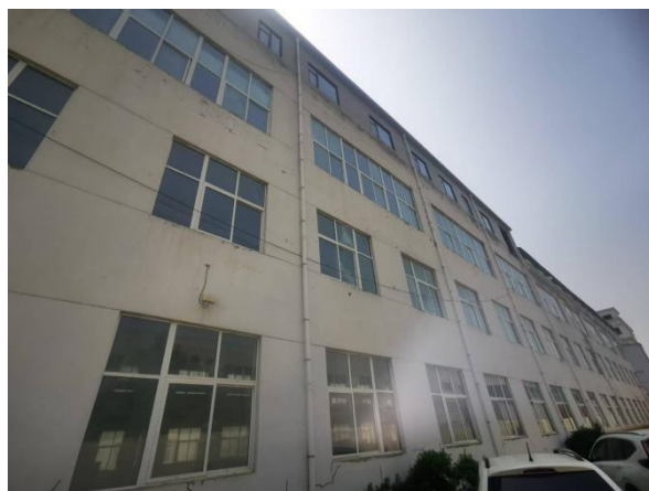
项目所在厂房外部
