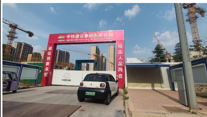
北侧--东梁佳苑（在建梁庄安置小区）
