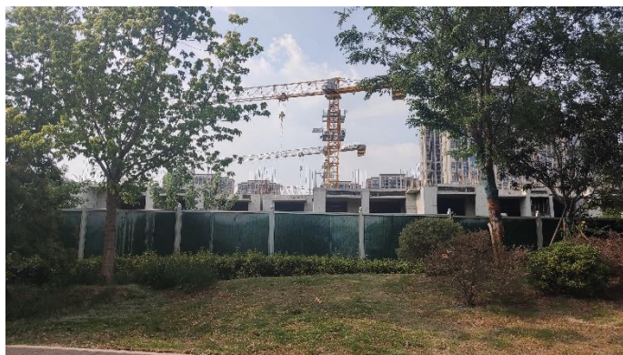
东侧-东梁佳苑（在建梁庄安置小区）
