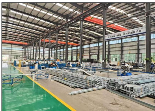
现有项目车间现状
