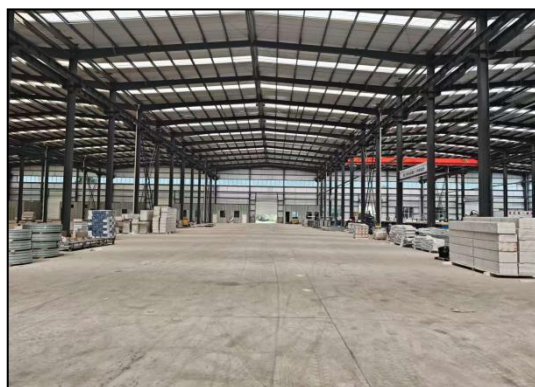
本项目拟建车间现状
