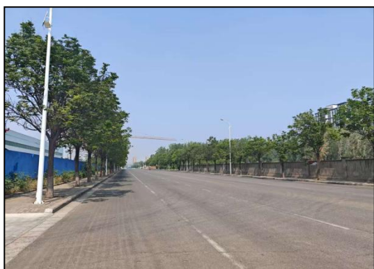
厂区北侧永盛街
