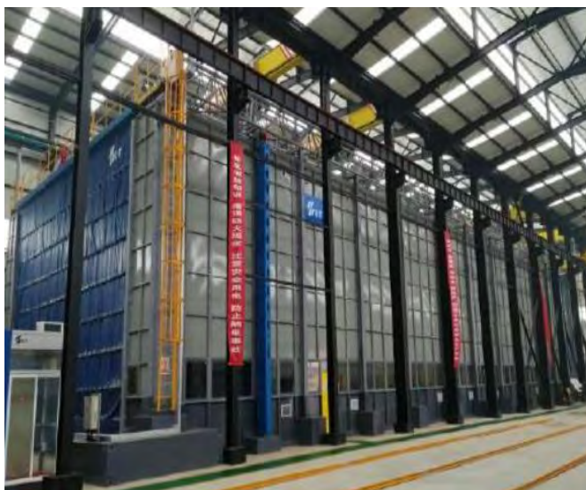
图 5.1-2 同类企业前处理废气收集措施实物图
