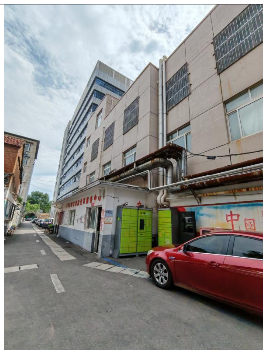
拟改建址东侧家属院道路
