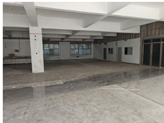
项目车间西侧闲置厂房
