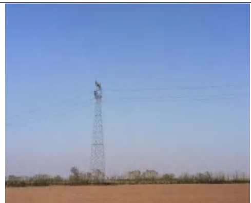
跨越禹杨 110kV 线路
