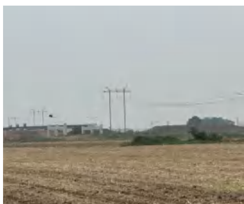
钻越涂付 220kV 线路
