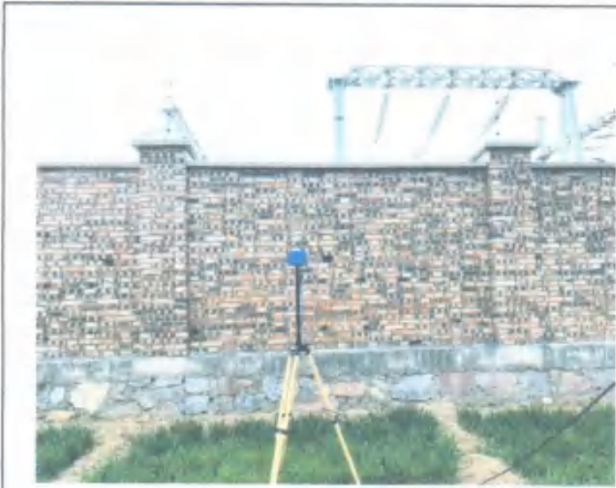
姚屯110kV变电站东侧围墙外电磁检测照片
