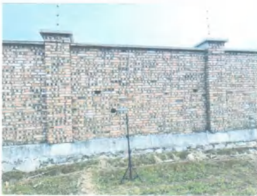
姚屯110kV变电站北侧围墙外噪声检测照片
