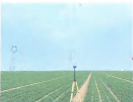
单回架空线路下(110kV新姚T褚姚线50#-51#塔基之间)电磁检测照片
