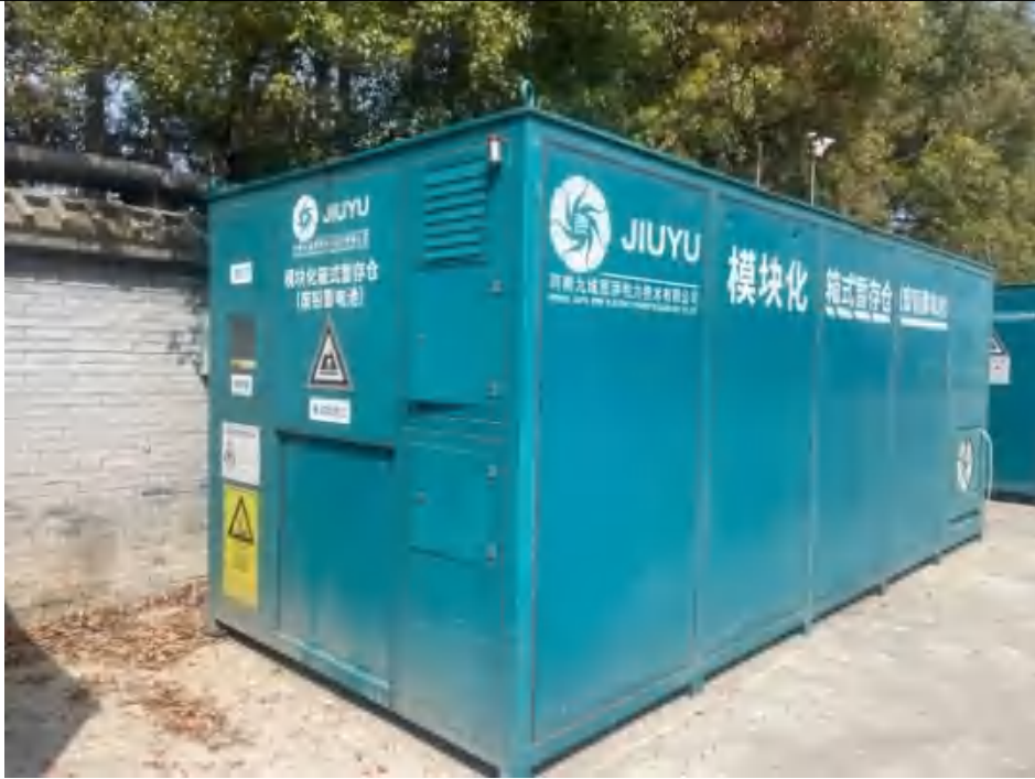
图 4-4 国网许昌市供电公司废铅蓄电池暂存仓照片
