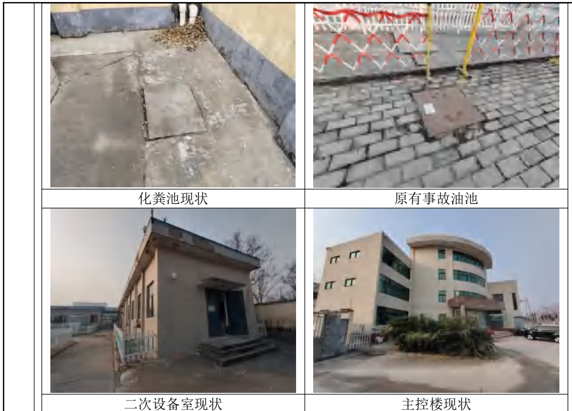
图 2-4 变电站现状照片
