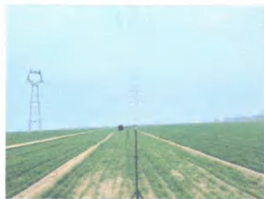
单回架空线路下(110kV新姚线50#-51#塔基之间)电磁检测照片
