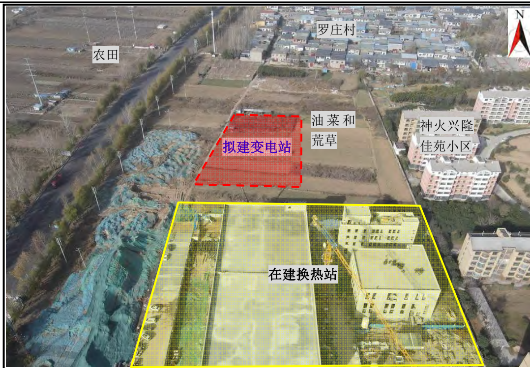
图 3-1 项目站址周边现状照片
