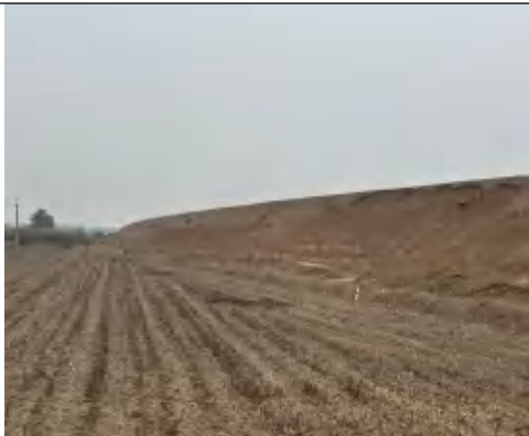
跨越在建郑南高速公路
