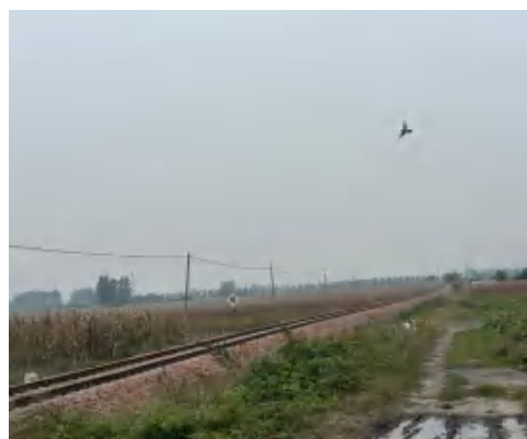
跨越三洋铁路（禹亳铁路）
