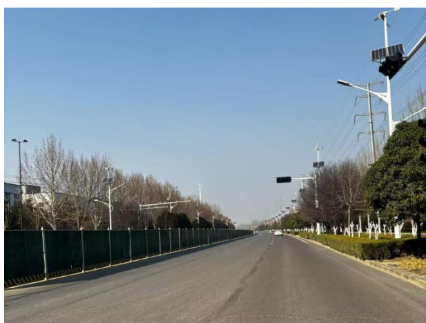
项目东侧—许州路
