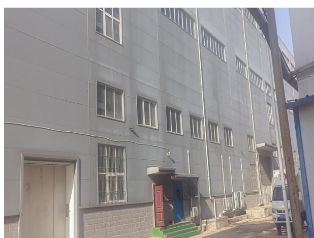
项目西侧—空厂房
