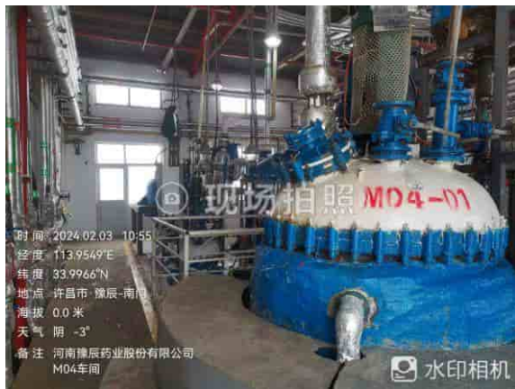
M 车间现状
