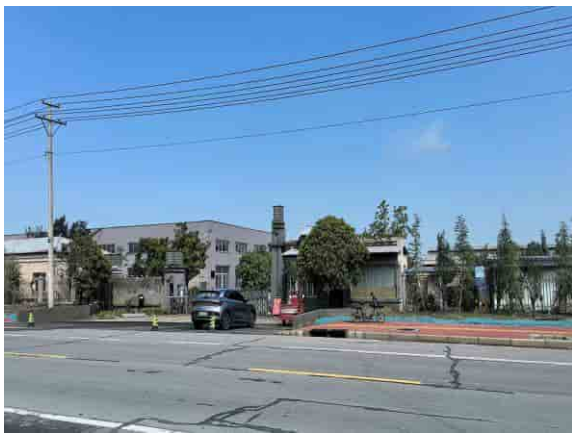
厂区西侧凯特化工
