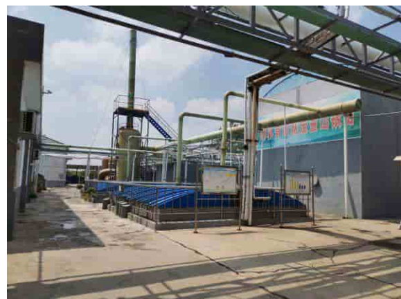
污水处理站环保设施拆除前现状
