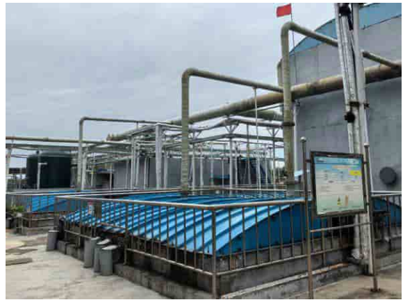
污水处理站现状
