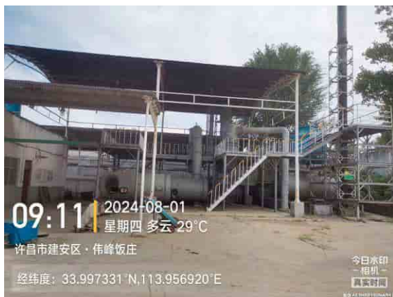
原危废焚烧炉
