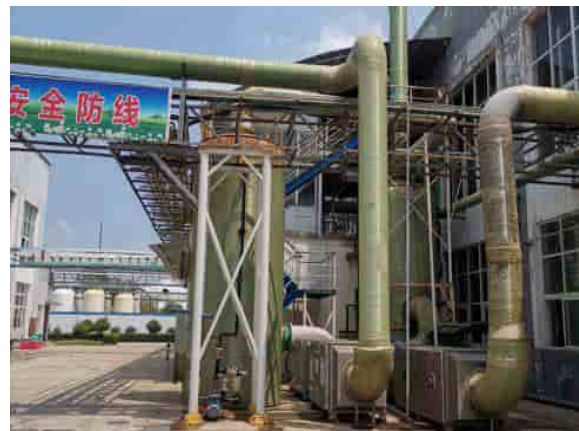
A06/A07 车间 UV 光氧+活性炭拆除前现状
