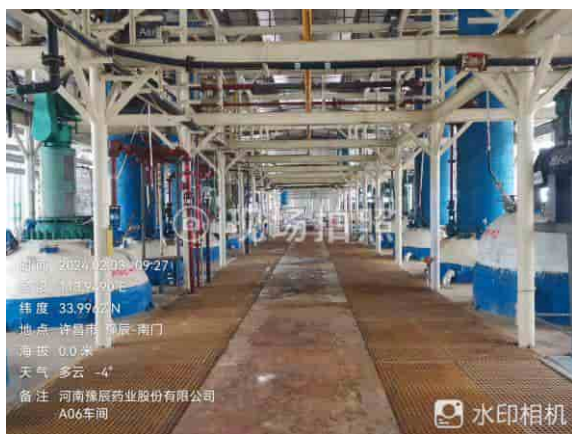
A06 车间现状
