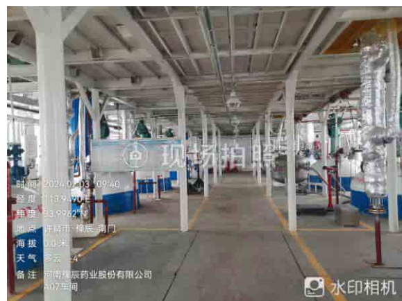
A07 车间现状
