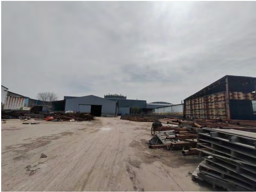
图 4-2 现场场地照片
