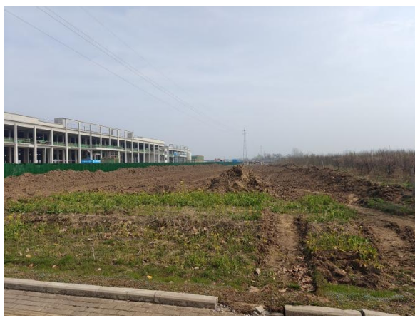
所在园区南侧现状
