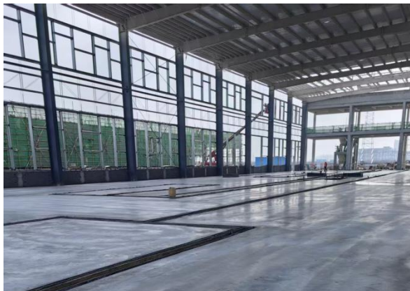
项目电泳车间现状
