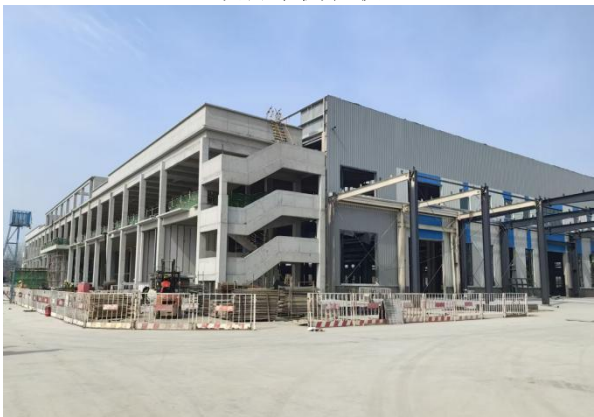
项目厂房西侧汇众焊接车间
