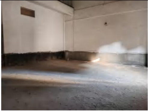
拟建 2#主变区域现状
