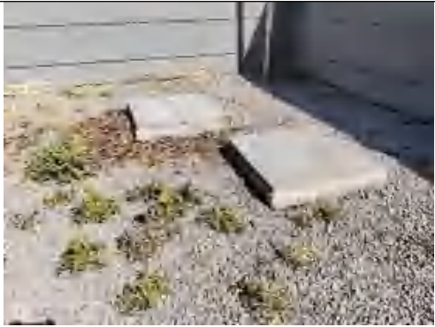
事故油池现状
