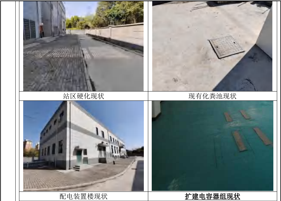
图 2-4 变电站现状照片
