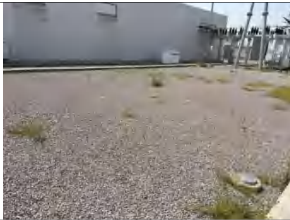
拟扩建 3 号主变压器预留区域
