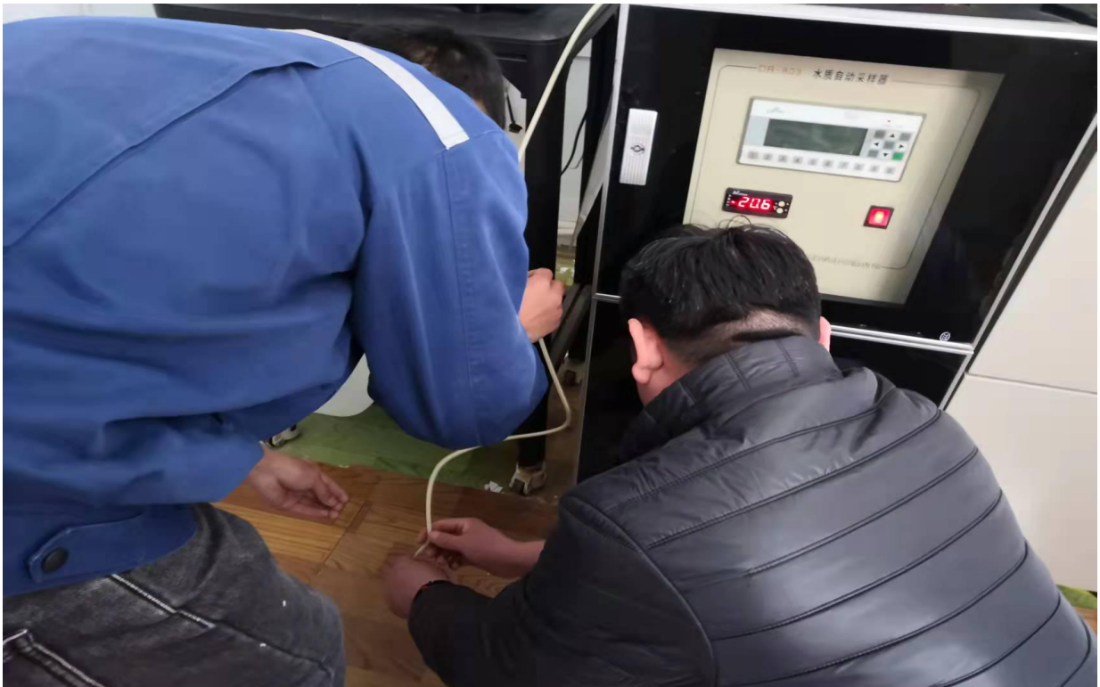
对该污水净化站，排污口在线监控设备进行检查、分析比对。
