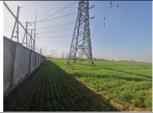
建安 110kV 变电站站外北侧
