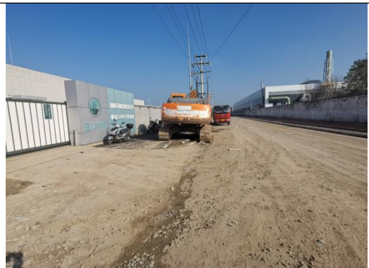
建安 110kV 变电站站外南侧
