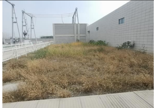
拟建 2#主变压器预留区域
