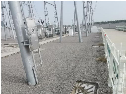
站内硬化及碎石铺装
