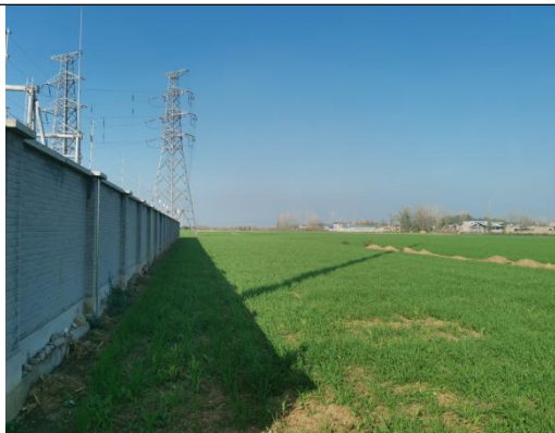
建安 110kV 变电站站外东侧
